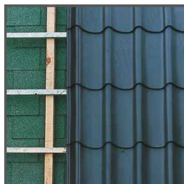
rénovation sur toiture bitumée
